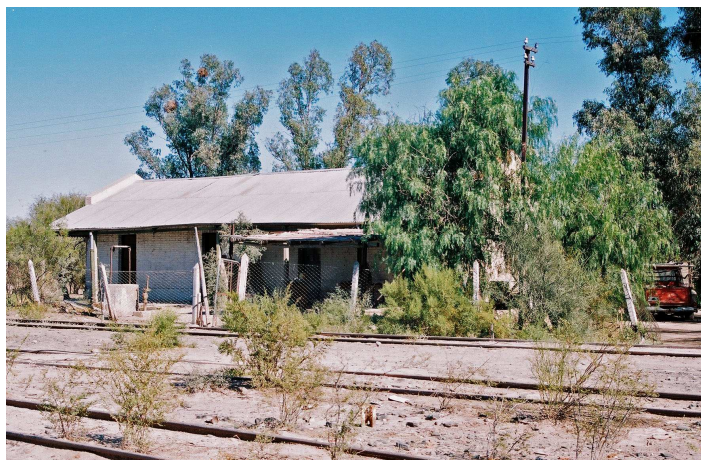
Casilla antiguamente perteneciente a la estación de tren
