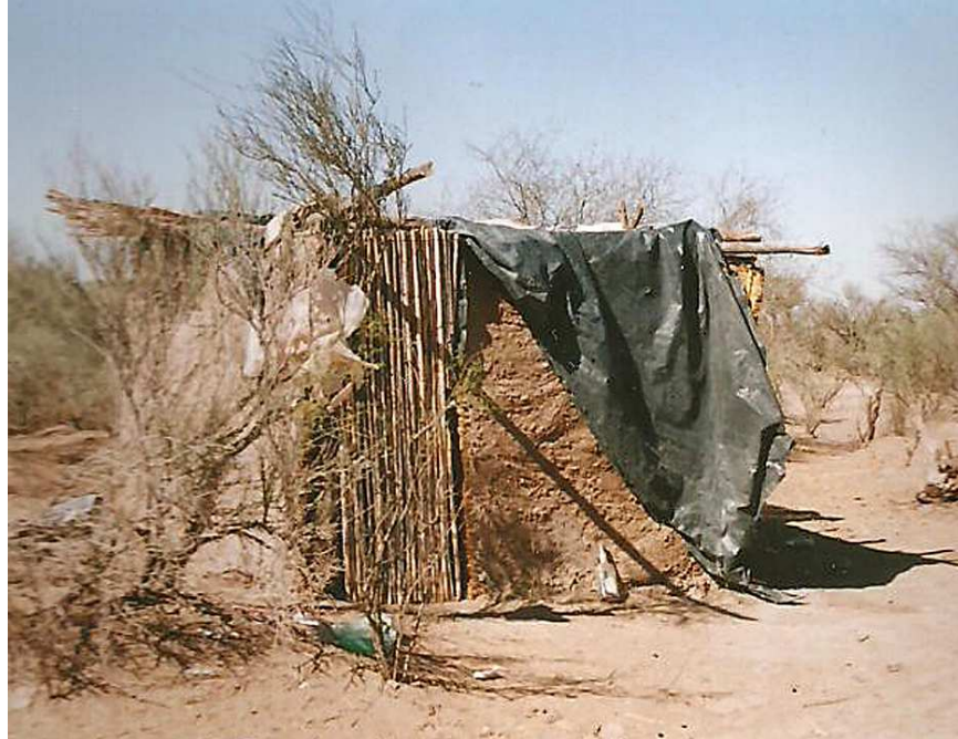
Vivienda tipo “quincha” construida con barro, caña y nylon
